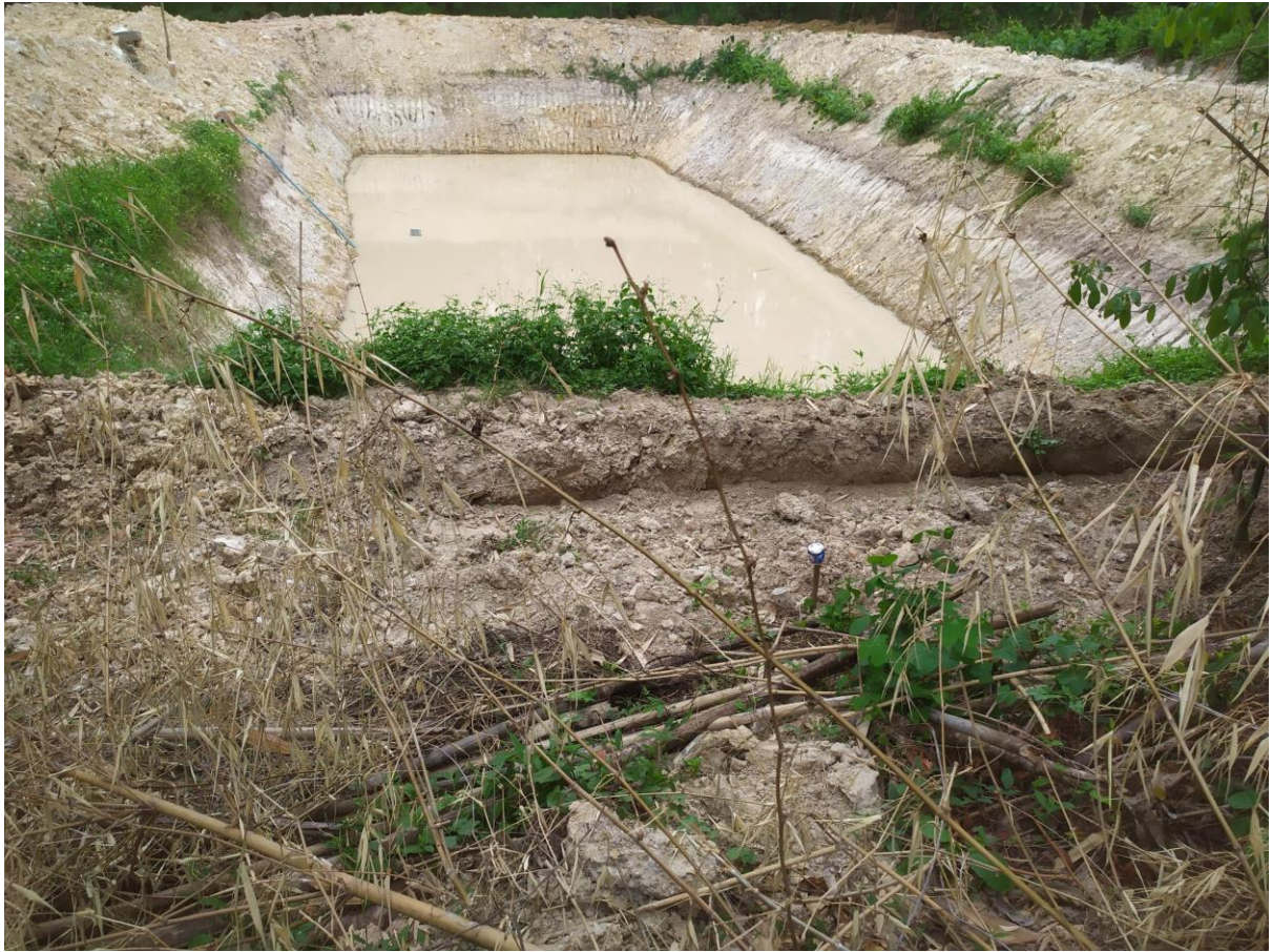
(ได้ดำเนินการขุดดินเพื่อสำหรับใช้เป็นทางน้ำสาธารณะประโยชน์แล้ว)
